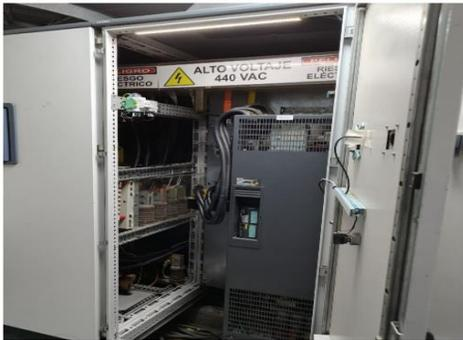
**CAMBIO DE TOTALIZADOR DEL VARIADOR DE FRECUENCIA:** Se requiere para el funcionamiento del variador de frecuencia encargado del funcionamiento del sistema de bombeo que distribuye el agua potable hacia el distrito.
